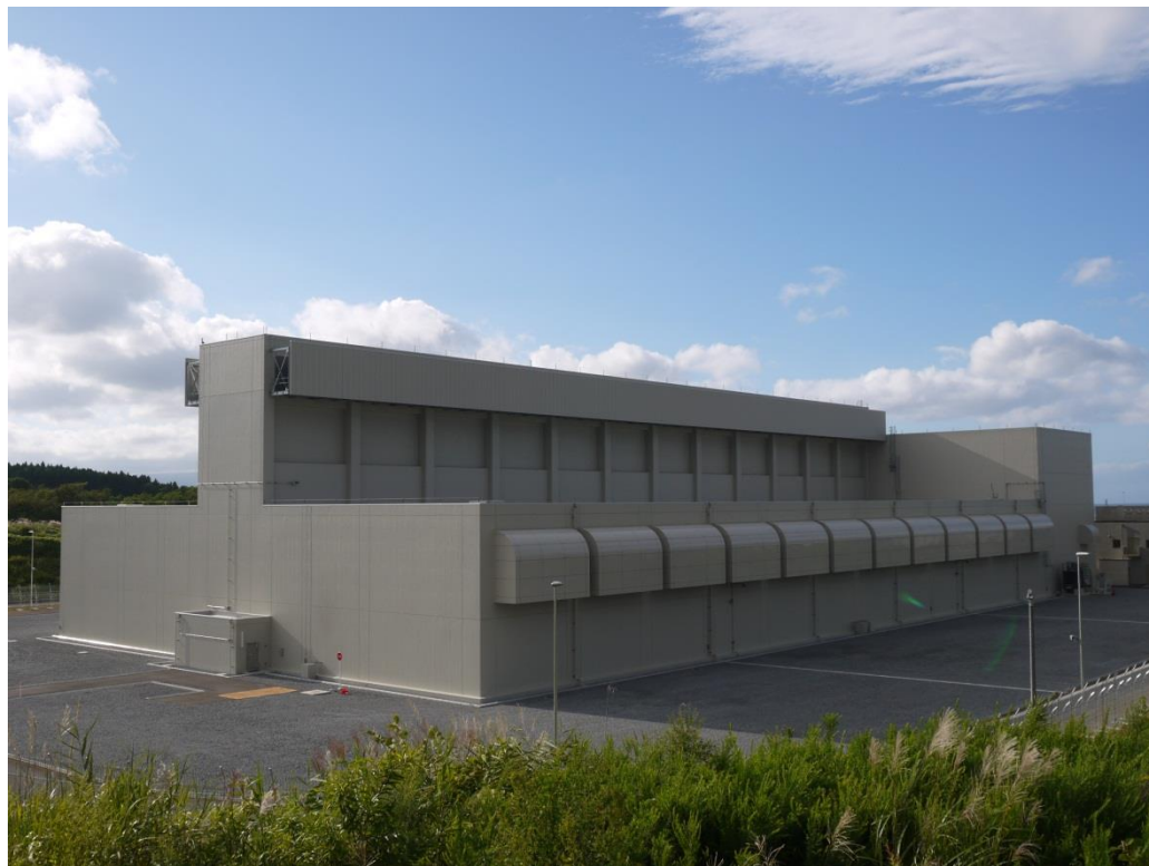
貯蔵建屋外観（南東方向から）
