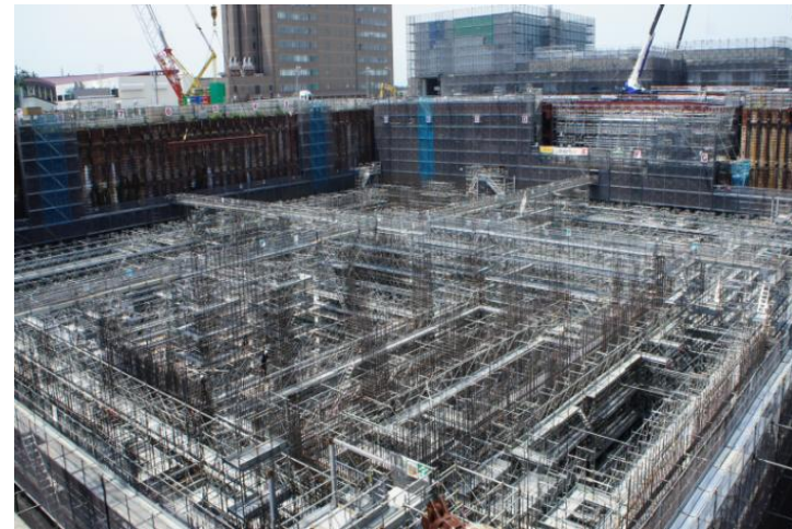
MOX燃料工場 建設工事現場風景
