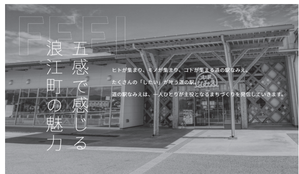
浪江町の賑わい拠点となっている道の駅なみえ
