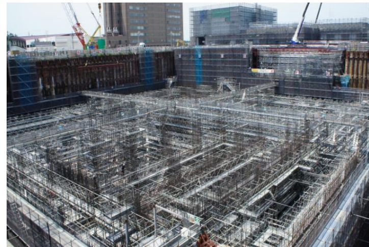
MOX燃料工場 建設工事現場風景
