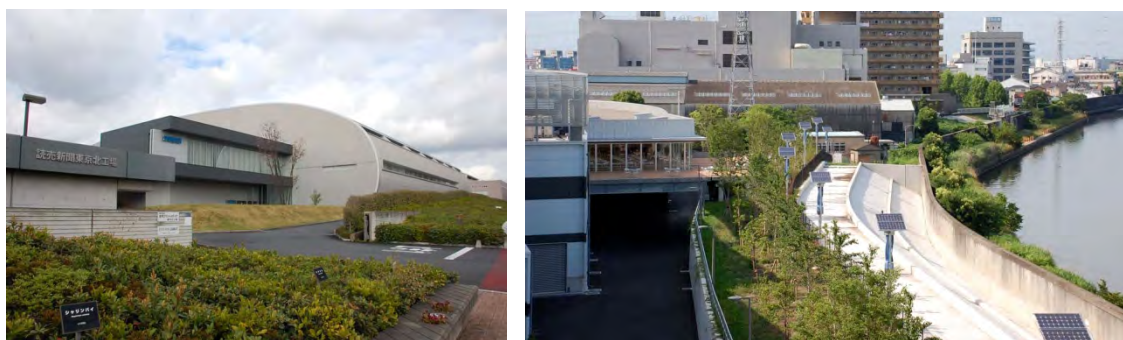
隅田川に面する新設工場
