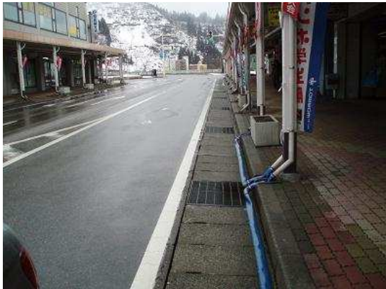
写真 9, 10 小出地区の流雪溝と「流雪溝発祥の地」の石碑（新潟県ホームページより）
