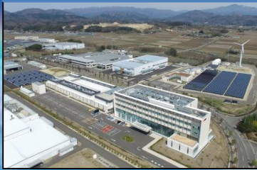
福島再生可能エネルギー研究所
